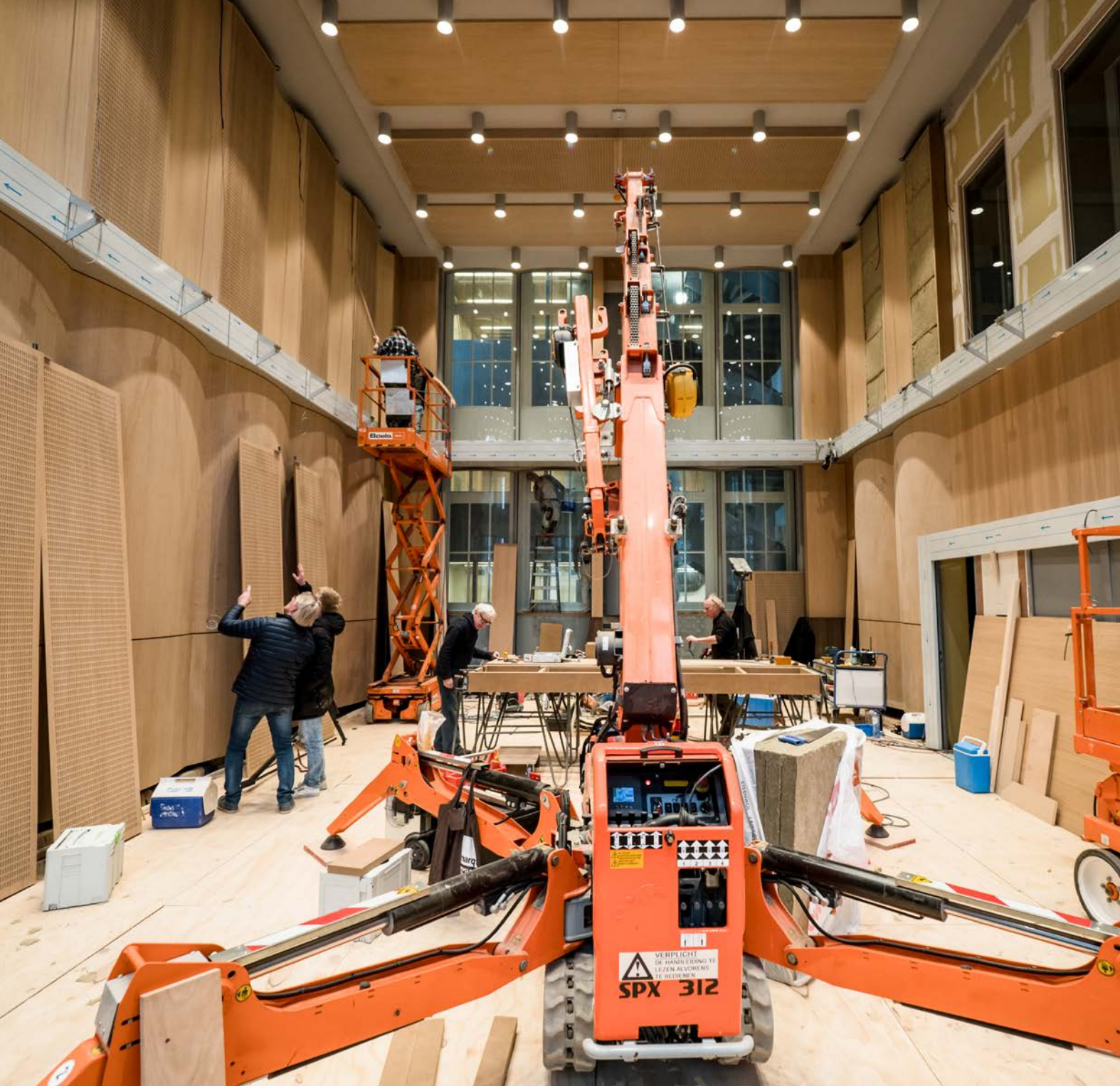
Eindfase van de verbouwing van de Amsterdamzaal. Een gespecialiseerd team van timmerlieden monteert de beweegbare akoestische wandpanelen
